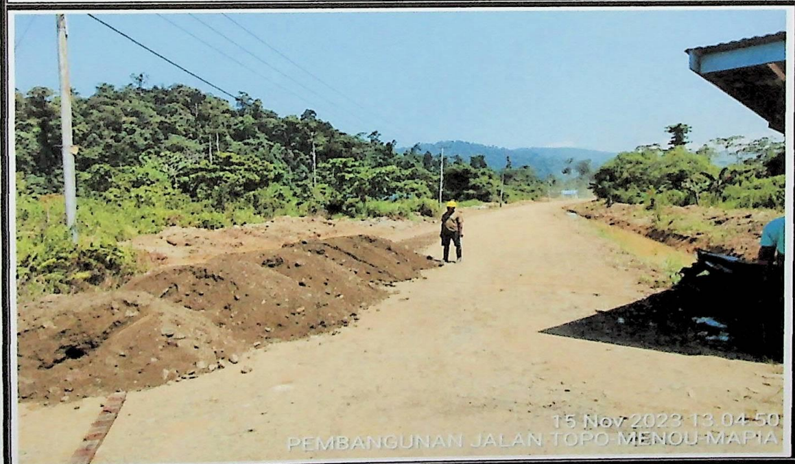
Pekerjaan urungan pilihan
