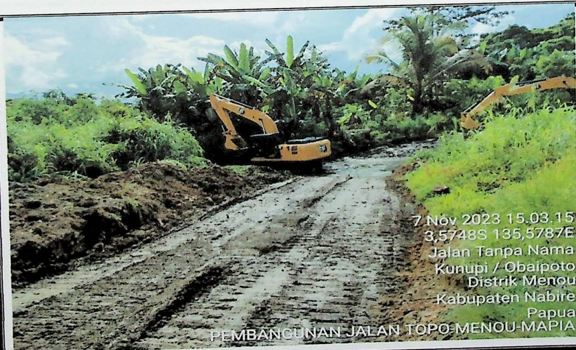
pekerjaan land cliring
