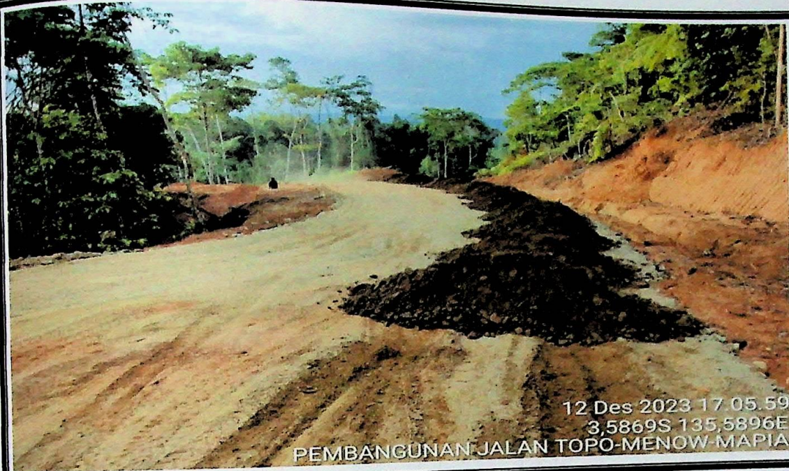
Pekerjaan timbunan Pilihan
