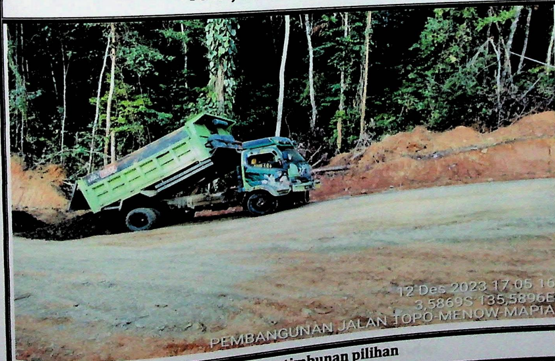
Pekerjaan timbunan Pilihan
