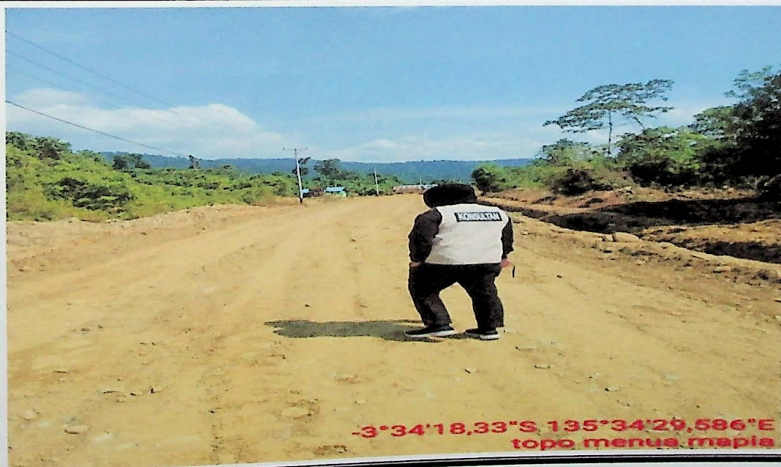
Pekerjaan telah mencapai 39,71 %
