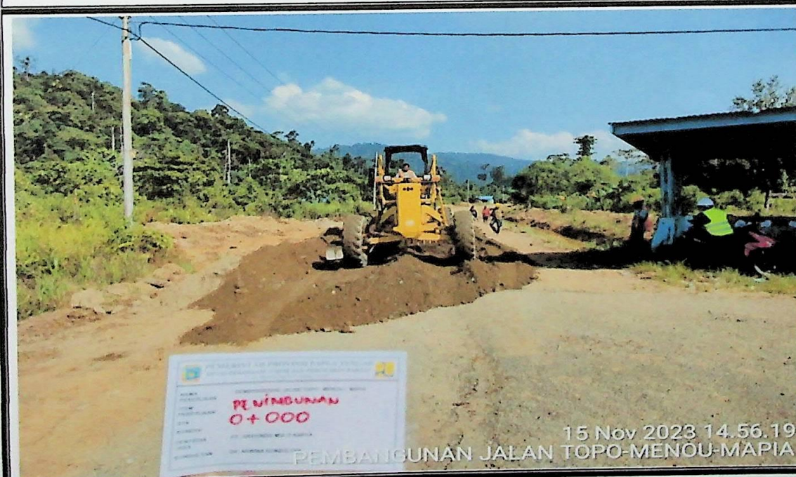
Pekerjaan penghamparan urungan pilihan
