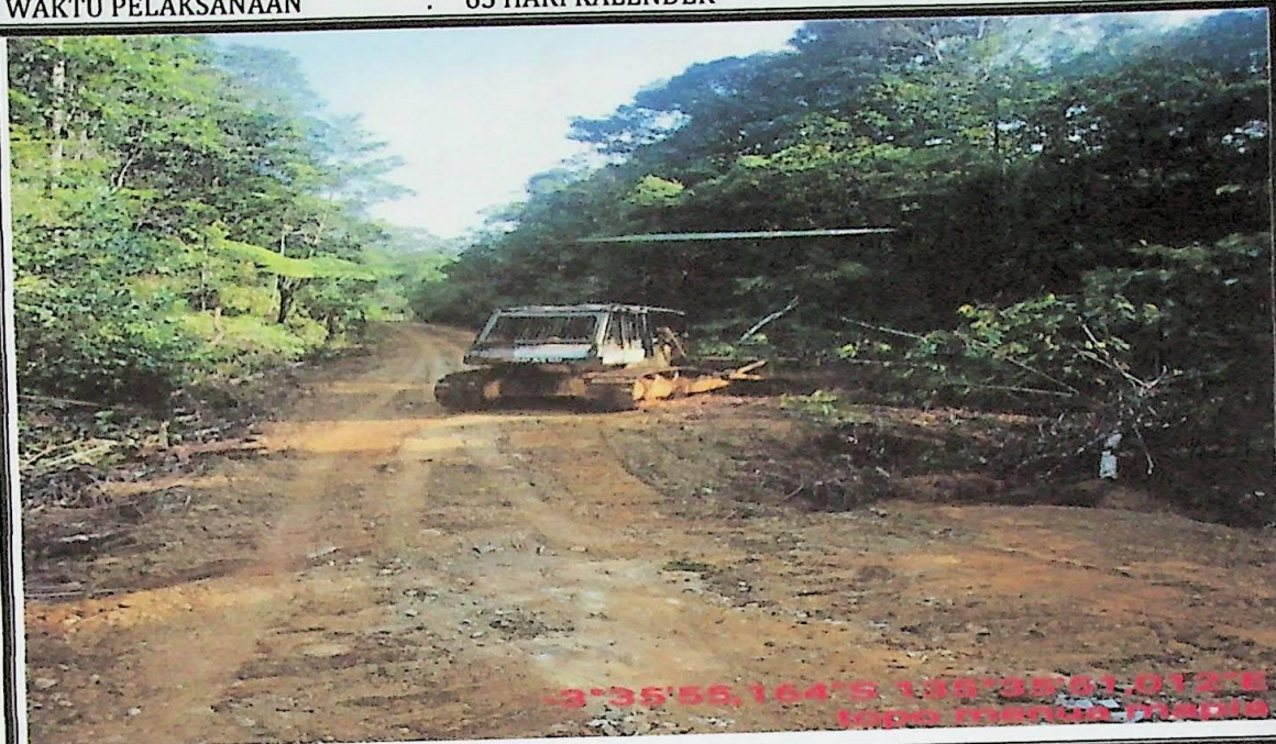
Pekerjaan land cliring
