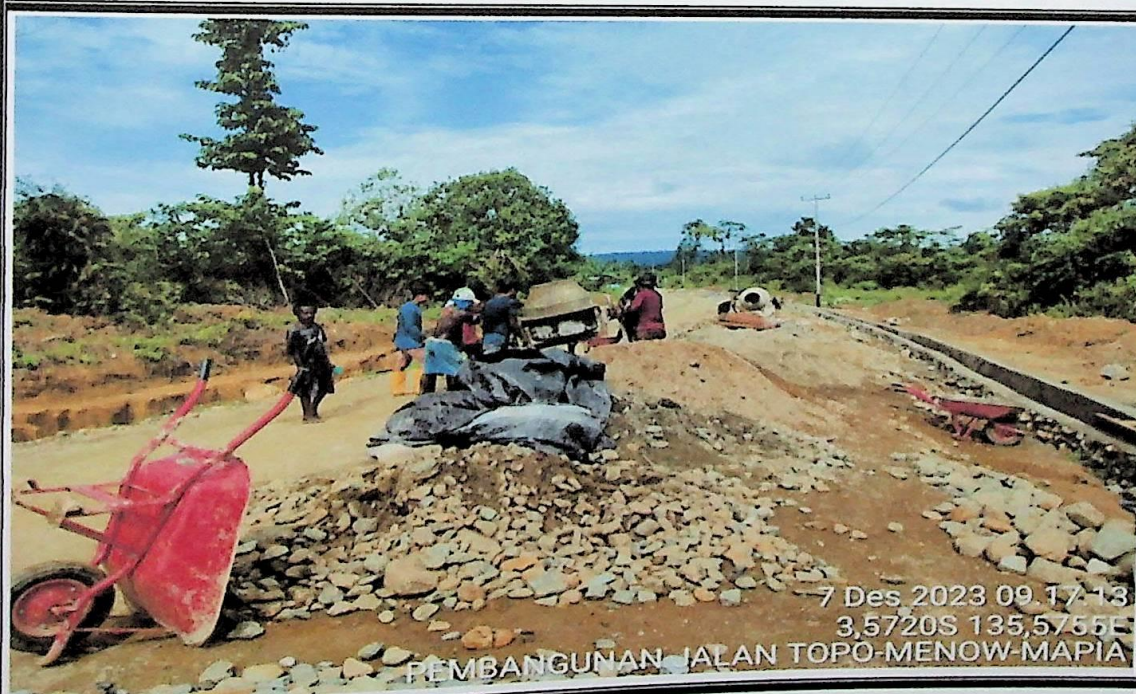
Pekerjaan pasangan batu dengan mortar
