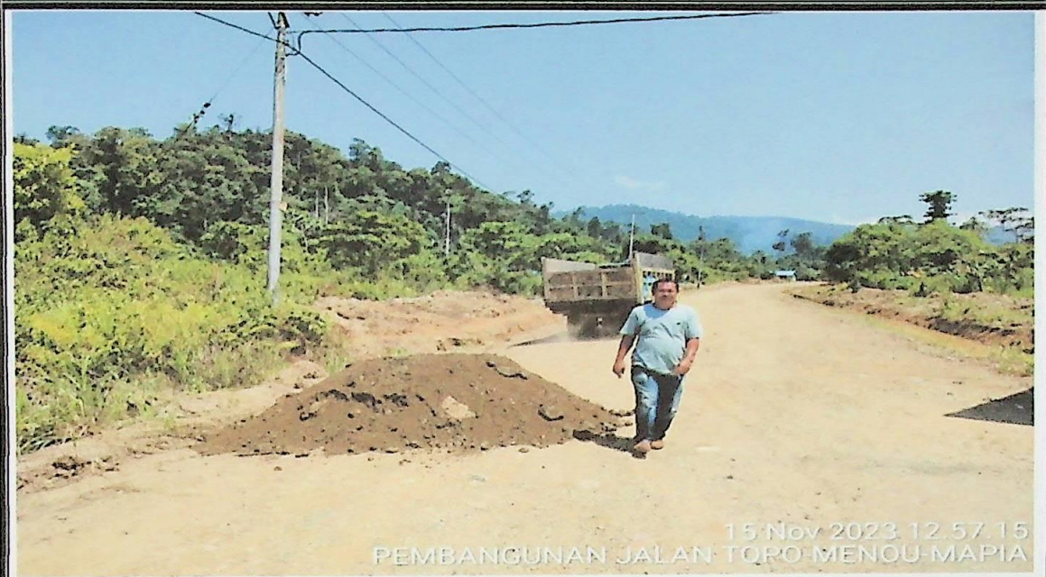
Pekerjaan urungan Pilihan
