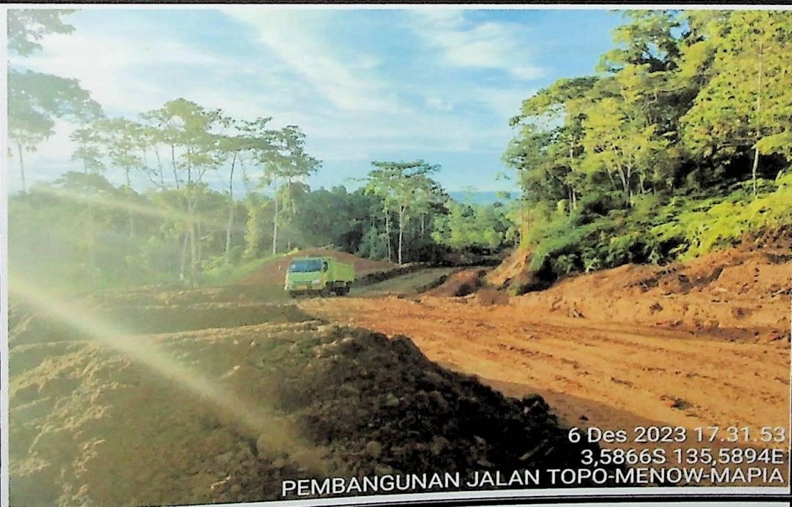
Pekerjaan timbunan pilihan
