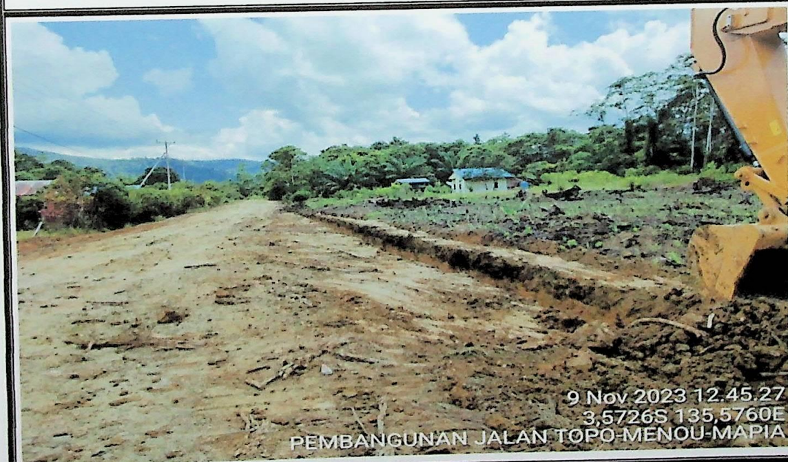
Pekerjaann galian saluran
