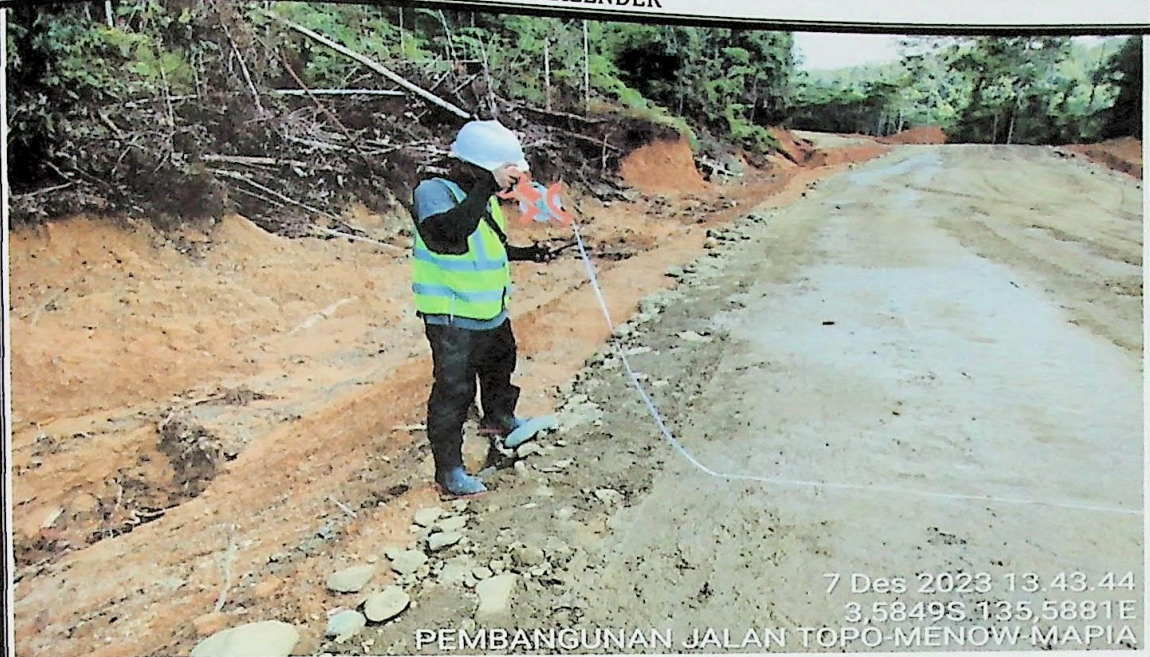
Opnam pekerjaan urungan pilihan
