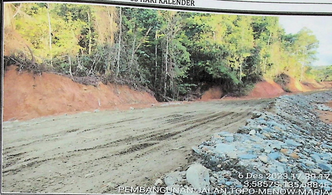
Pekerjaan penghamparan material pilihan
