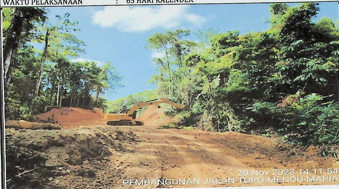
Pekerjaan galian biasa
