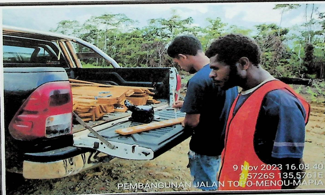
Pekerjaan Pemasangan Patok STA
