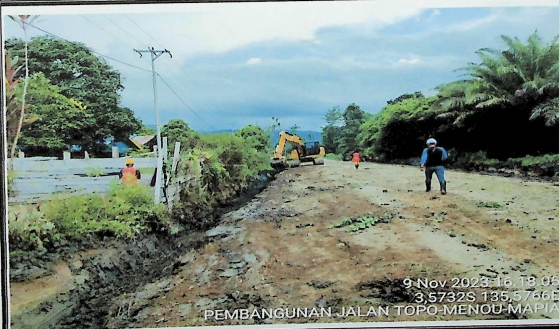
Pekerjaan galian saluran dan penyiapan badan jalan
