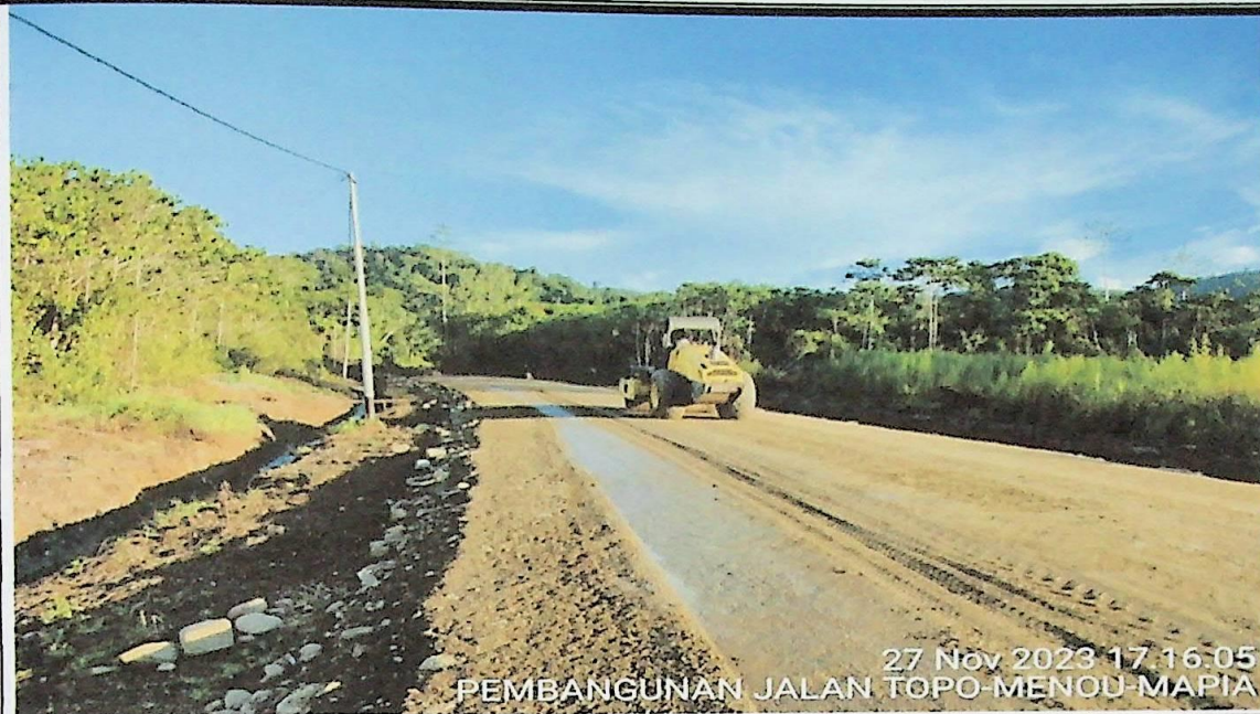
Pemadatan material pilihan
