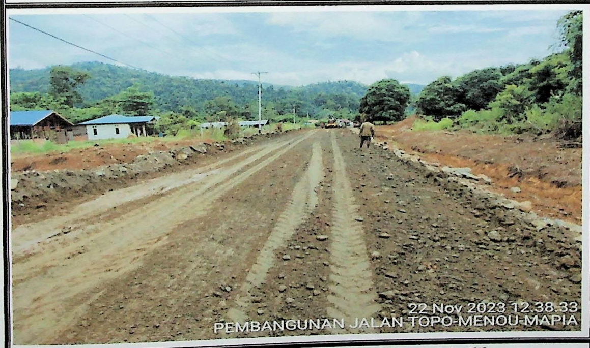
Pekerjaan penghamparan dan pemadatan material pilihan
