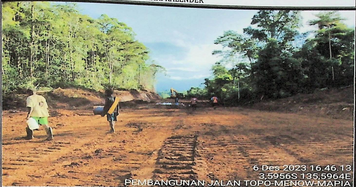
Pekerjaan galian dan penyiapan badan jalan
