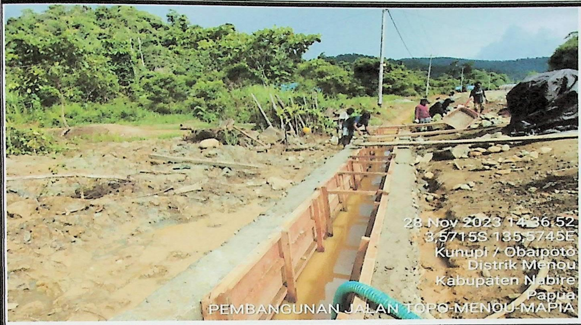
Pekerjaan pemasangan batu dengan mortar
