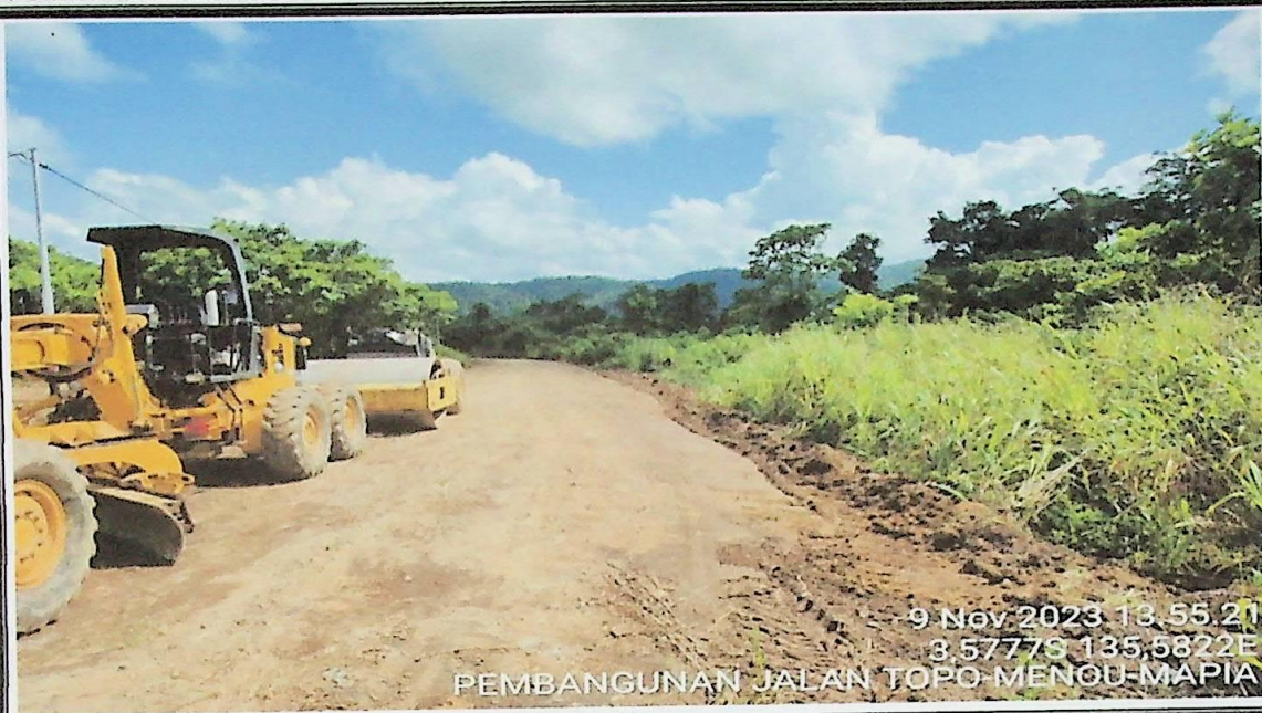
Pekerjaan Penyiapan badan jalan
