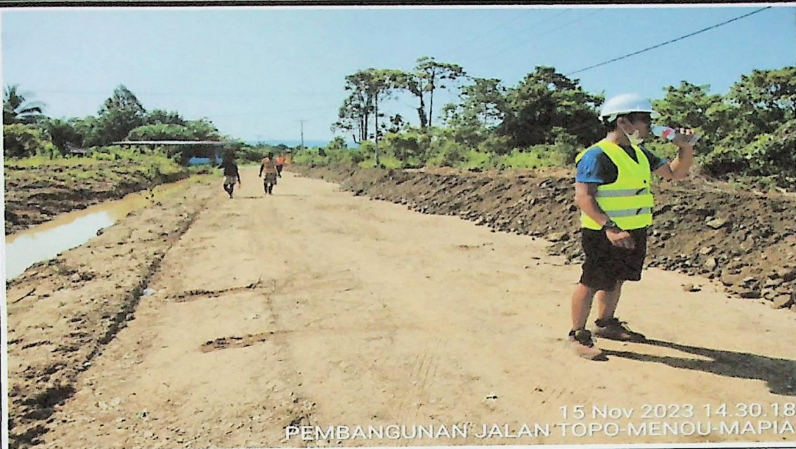
Pekerjaan urungan Pilihan
