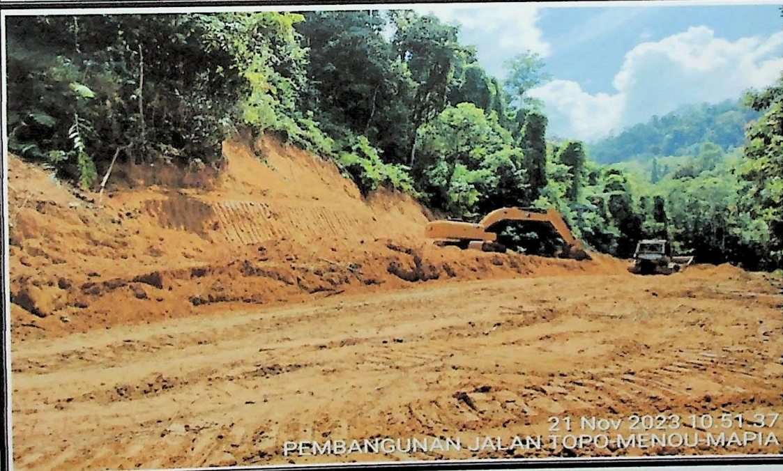
Pekerjaan galian dan penyiapan badan jalan
