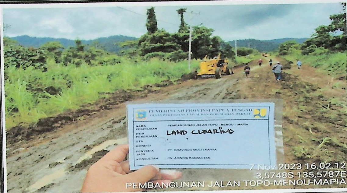
Pekerjaan land cliring
