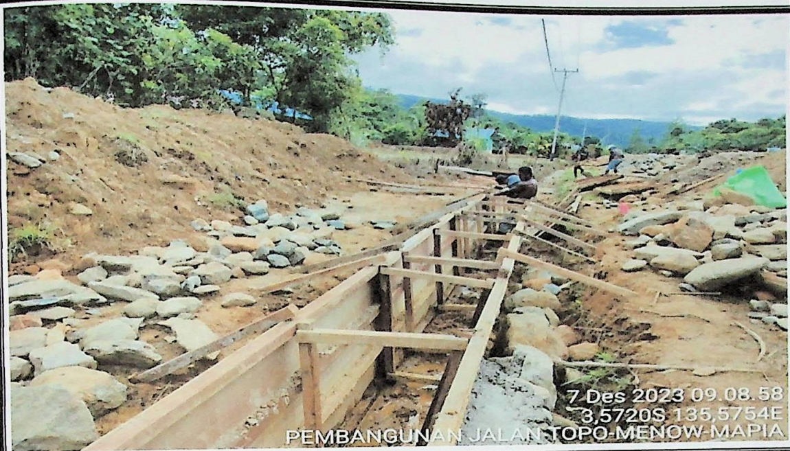
Pekerjaan pasangan batu dengan mortar
