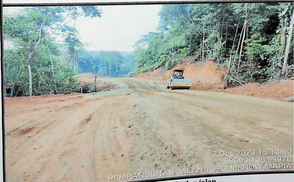
Pemadatan penyiapan badan jalan
