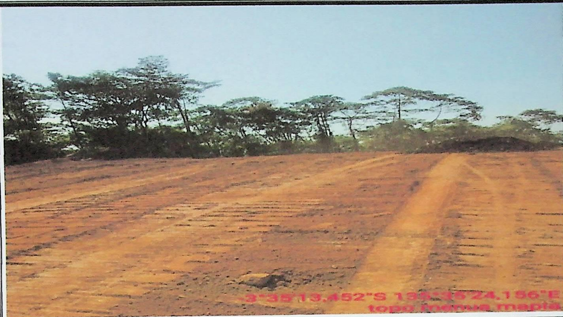
Pekerjaan penyiapan badan jalan
