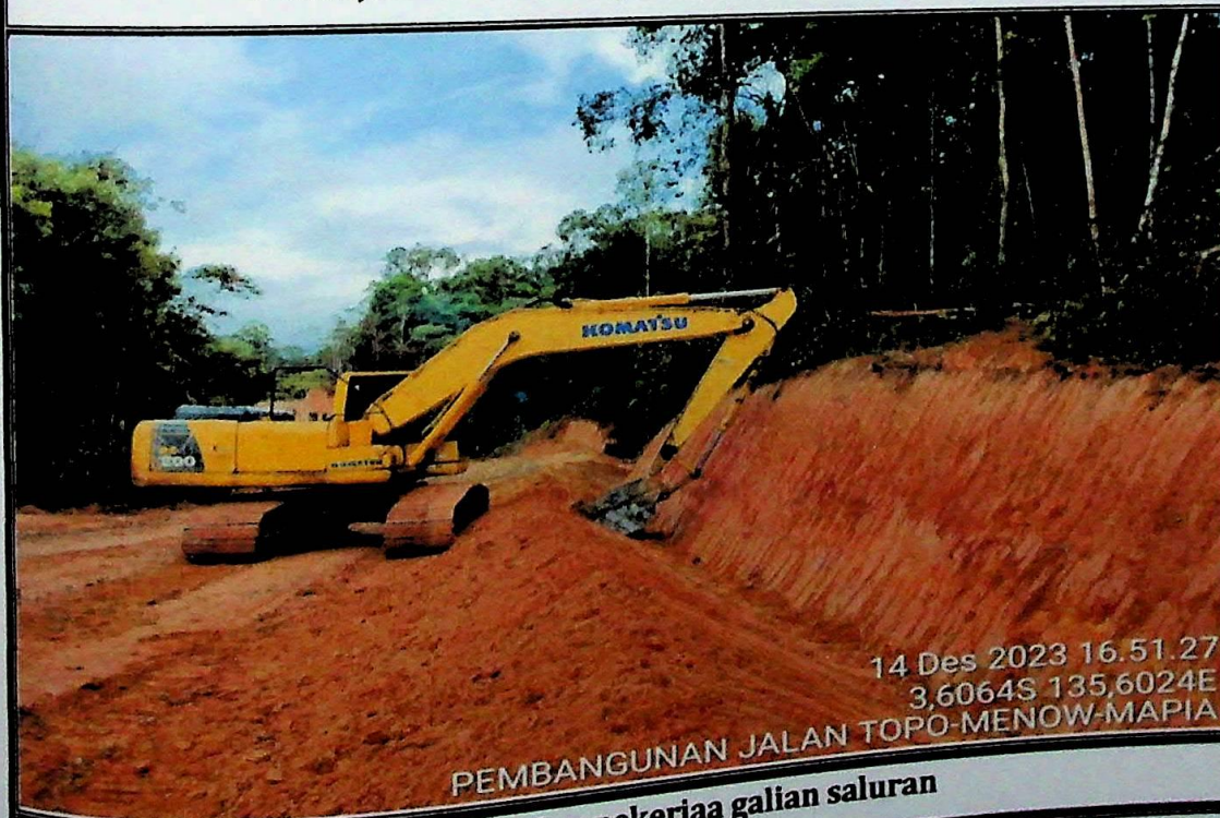
Pekerjaan Land cliring dan penyiapan badan jalan
