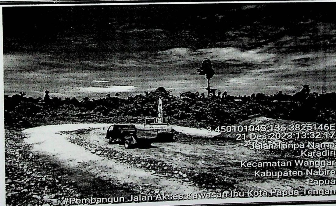
Pekerjaan GALIAN BIASA
