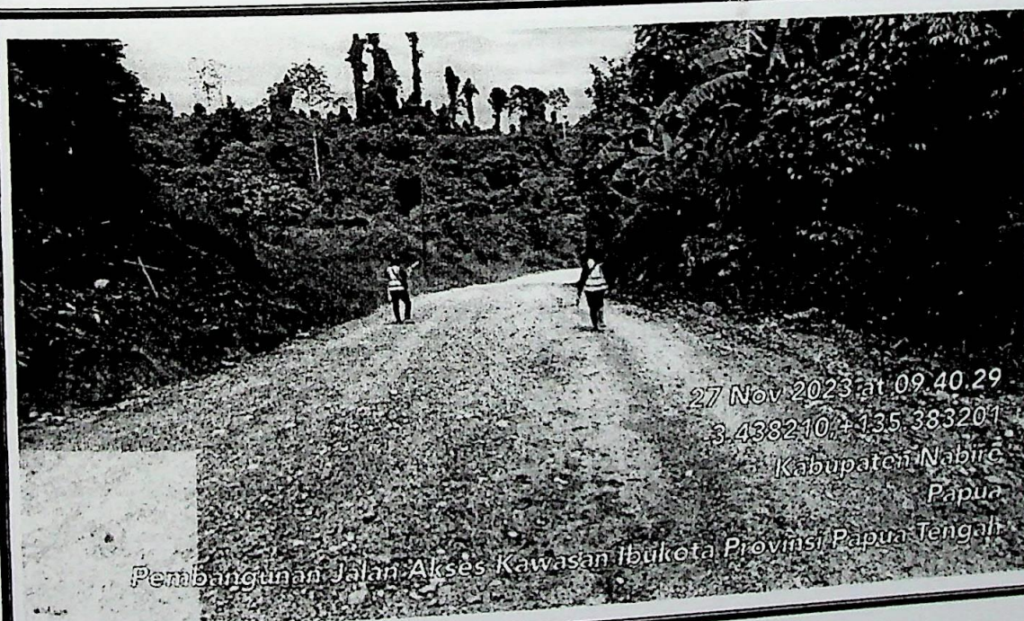
Pekerjaan GALIAN BIASA
