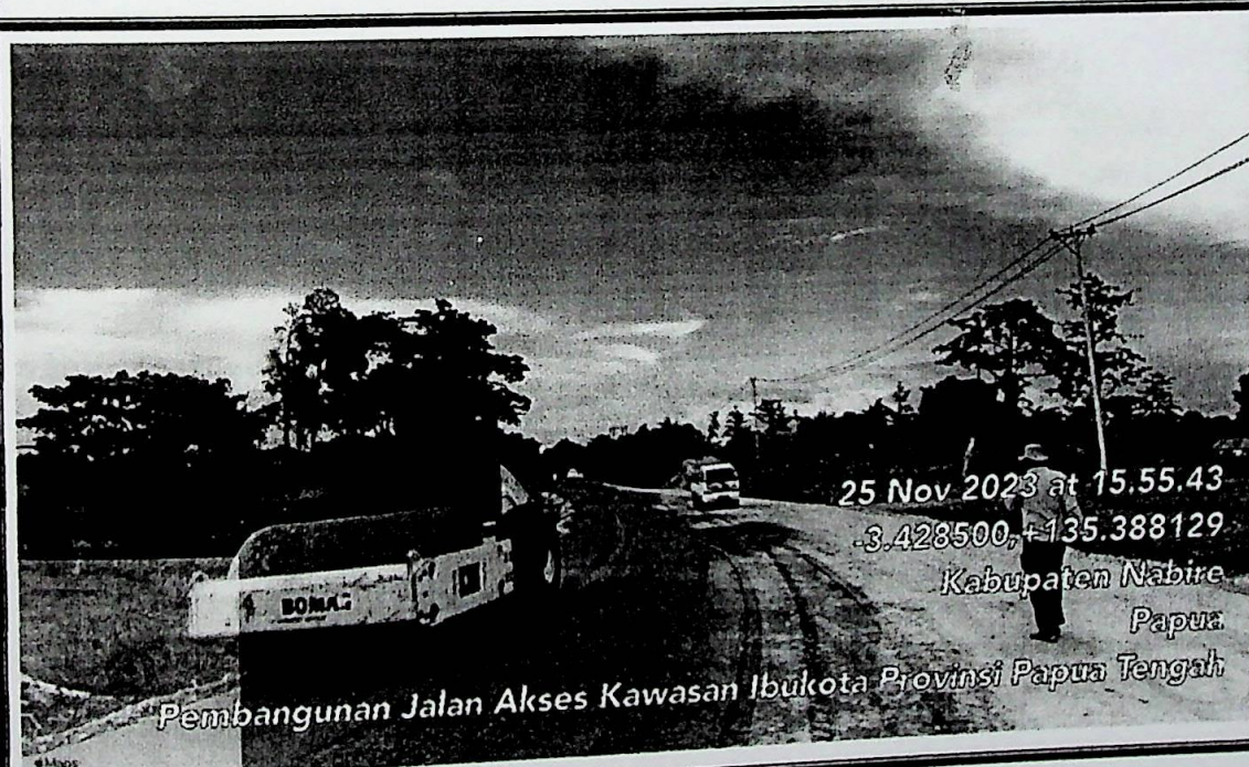
Pekerjaan penghamparan dan pemadatan material pilihan
