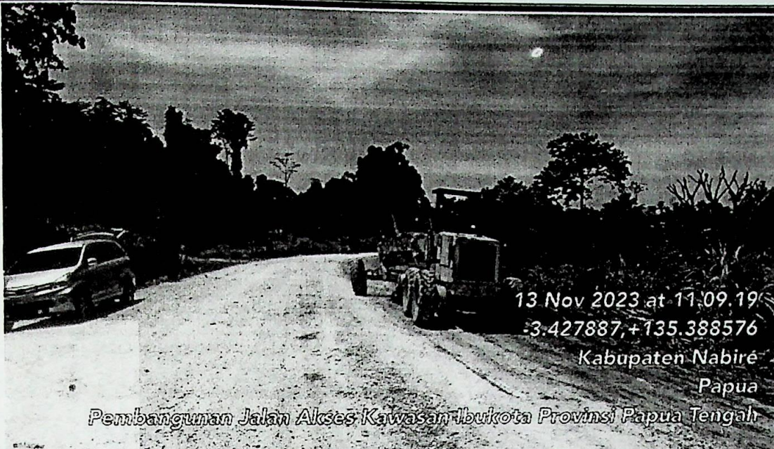
PENYIAPAN BADAN JALAN
