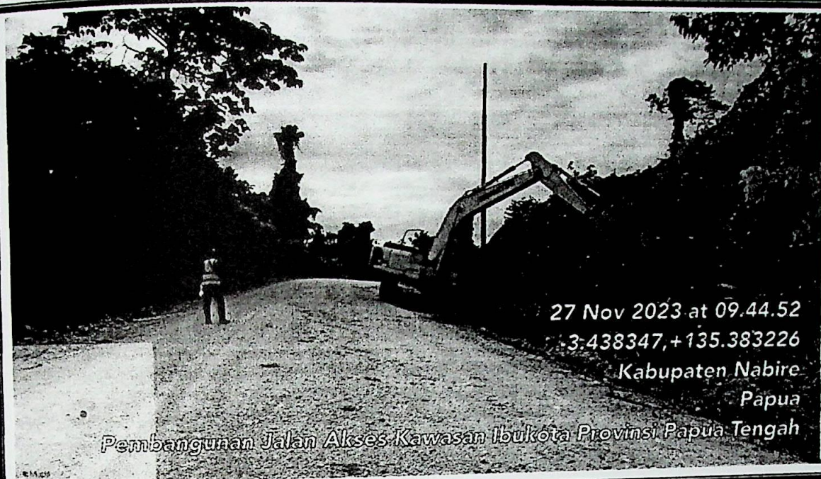
Pekerjaan GALIAN BIASA
