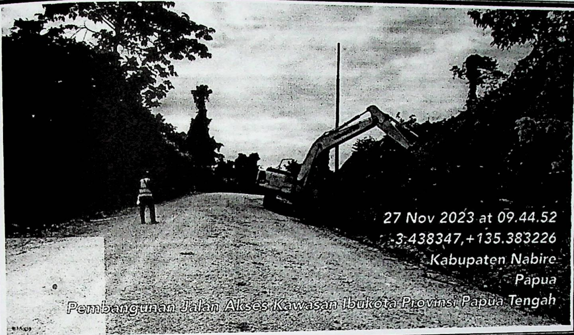
Pekerjaan GALIAN BIASA
