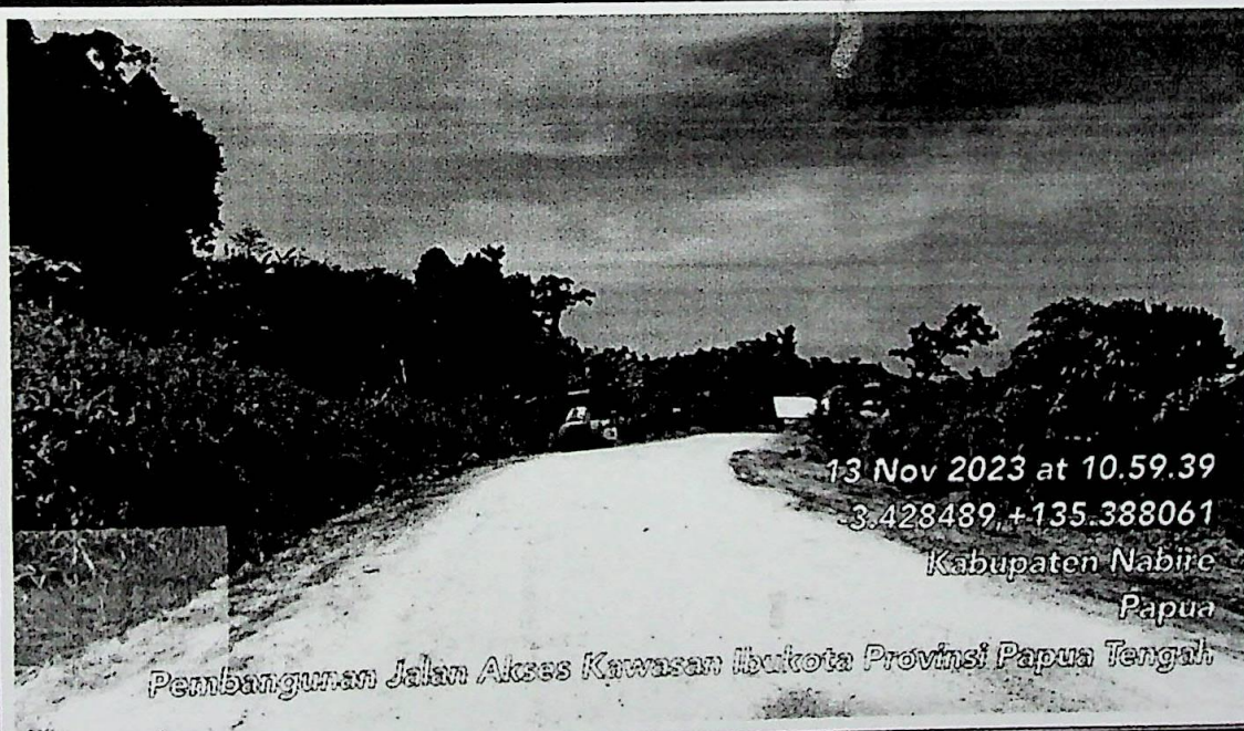
PENYIAPAN BADAN JALAN
