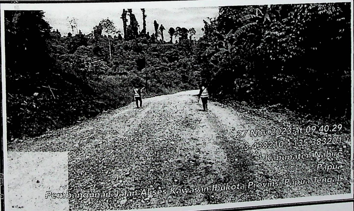
Pekerjaan GALIAN BIASA
