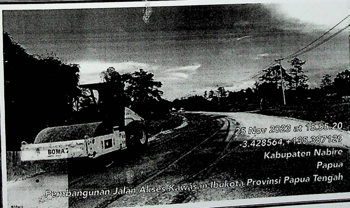
Pekerjaan penghamparan dan pemadatan material pilihan
