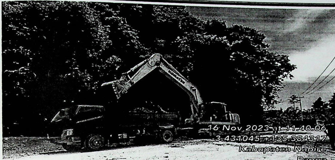
Pembangunan Jalan Akses Kawasan Ibukota Provinsi Papua Tengah
