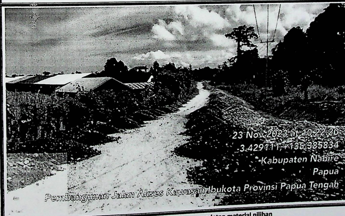
Pekerjaan penghamparan dan pemadatan material pilihan
