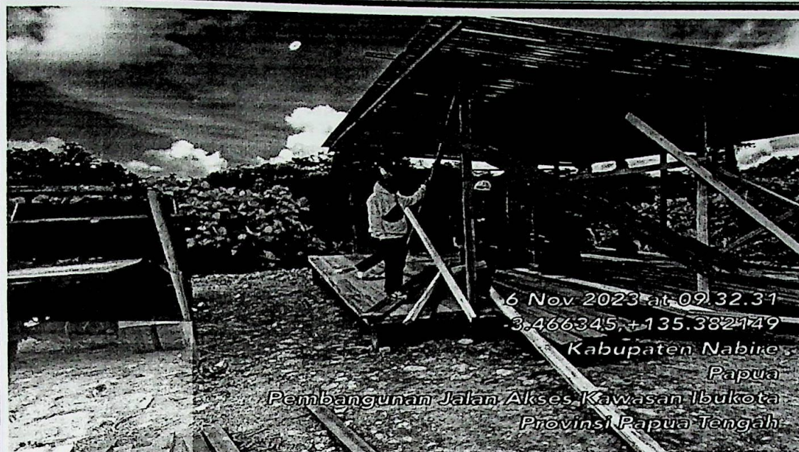
PEMBANGUNAN KAMP PEKERJA
