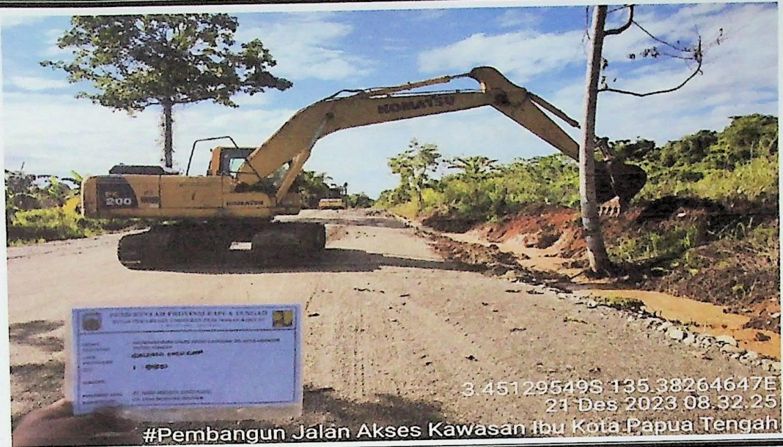
Pekerjaan GALIAN SALURAN
