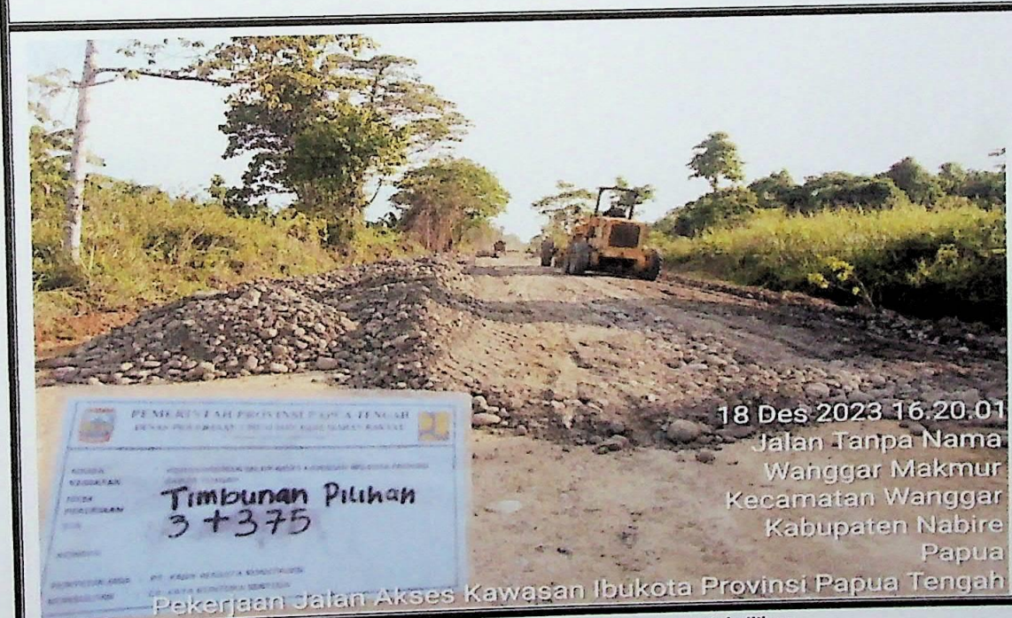
Pekerjaan penghamparan dan pemadatan material pilihan
