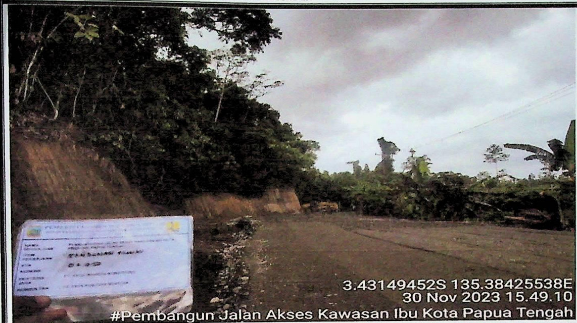
Pekerjaan urungan Pilihan
