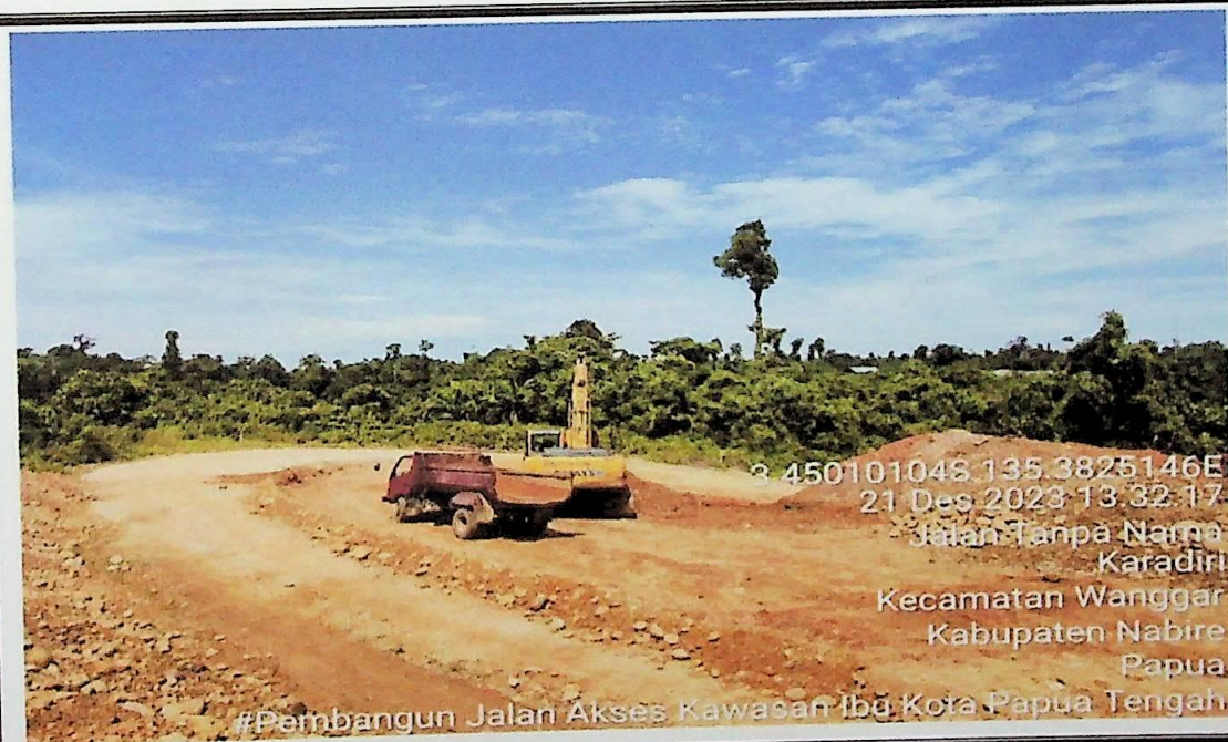
Pekerjaan GALIAN BIASA
