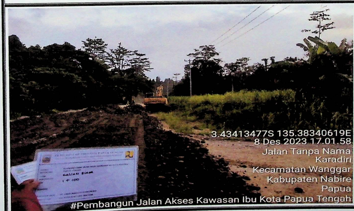
Pekerjaan urungan pilihan
