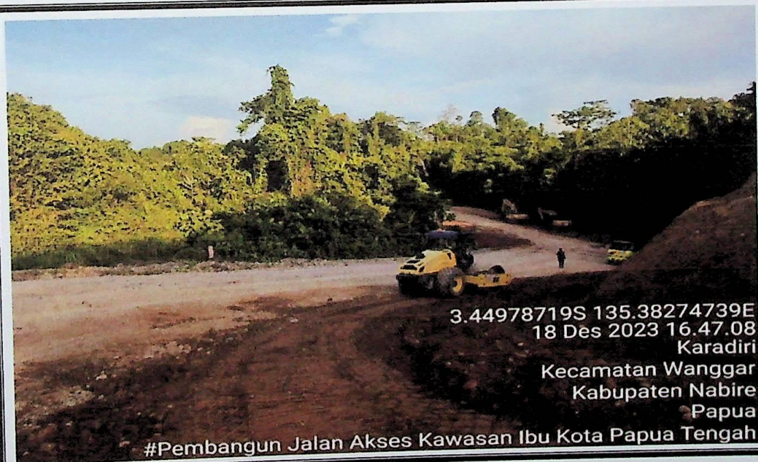
Pekerjaan penghamparan dan pemadatan
